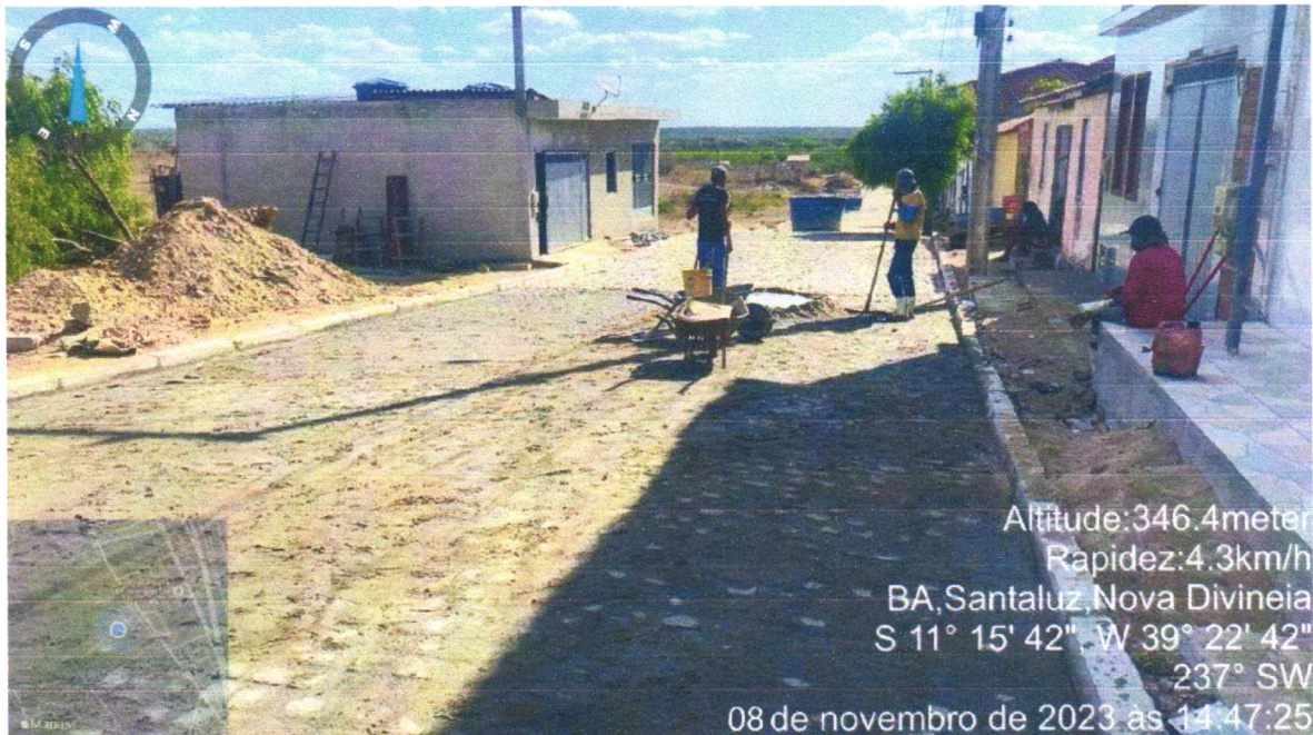
Execução de Pavimentação do Bairro Nova Divinéia, Rua F. Mascedo
